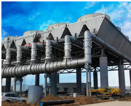
Рисунок 3. «Сухая» градирня шатрового типа
